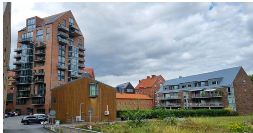
Modern bostadsbebyggelse och byggnader för kontor.
